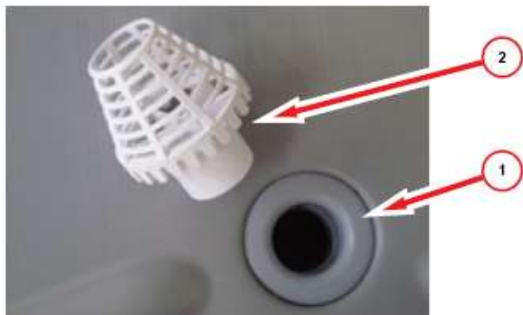
Rys. 13: Odpływ (1) z sitkiem odpływowym (2)
